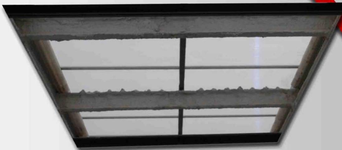
Los lucernarios son elementos constructivos que han evolucionado casi a la par con las diferentes soluciones para cubiertas, esto se debe a la necesidad de ofrecer luminosidad natural en superficies de gran tamaño cuyas dimensiones hacen demasiado expensivo un mantenimiento solo mediante luz artificial.
